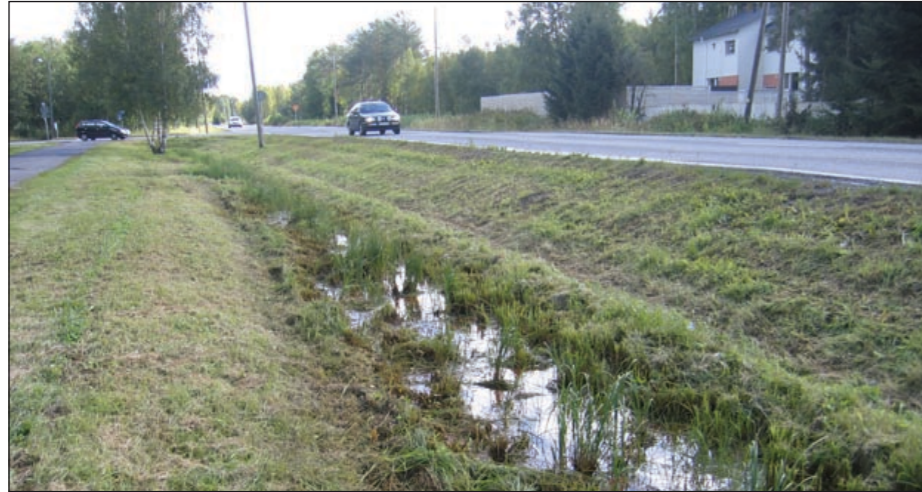
Kuva 14. Liettynyt sivuoja Kuivasjärvellä.
